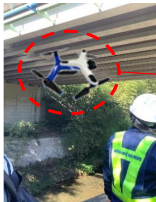
ドローンによる橋梁点検の様子
