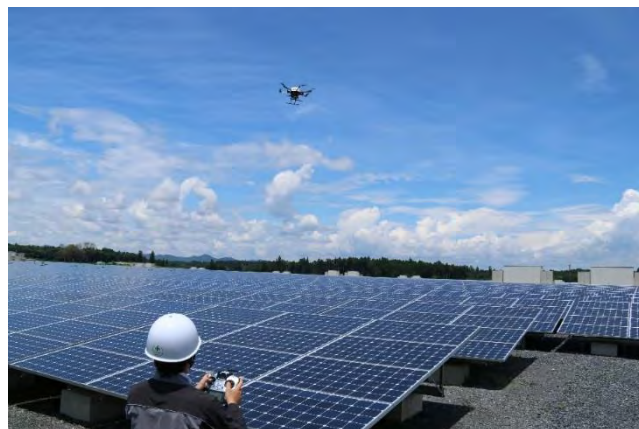
ドローンを活用したメガソーラー点検
