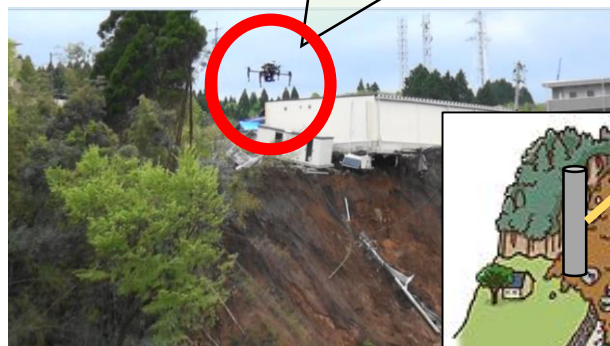
崖崩れをドローンで調査
